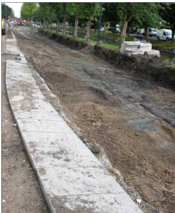
Afb. 3.26: Overzicht van de locatie van onderzoeksfase 9.
